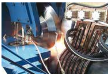
Электросварка труб HFI
