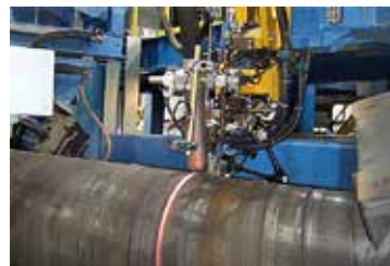
Процесс сварки под флюсом
