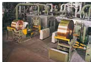
Горизонтальные установки непрерывной разливки для производства полос под холодную прокатку
