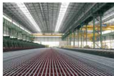
高速搬送システム HSD®付き冷却床
