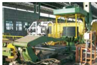
帯板結束ステーション
